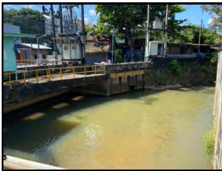
รูปที่ 2.2-11 ตำแหน่งสถานีสูบน้ำสถานีสูบน้ำโกมารภักดิ์ บริเวณสามแยกถนนโกมารภักดิ์
