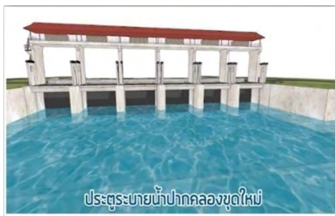
รูปที่ 2.2-3 ประตูระบายน้ำปากคลองชุดใหม่
